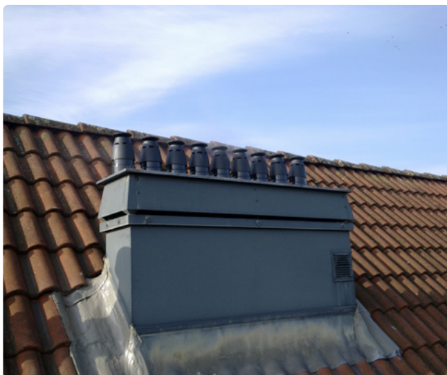
Dakdoorvoeren van individuele RGA
